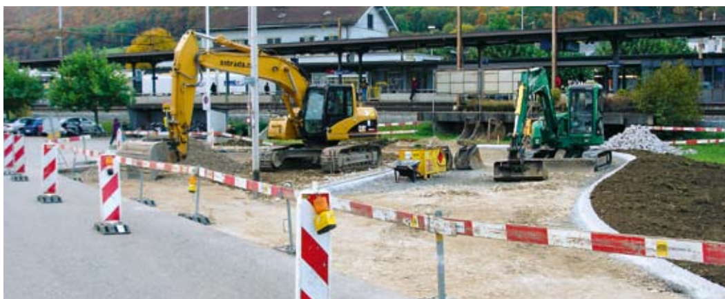
Neubau Buswendeplatz Bahnhof Oensingen
